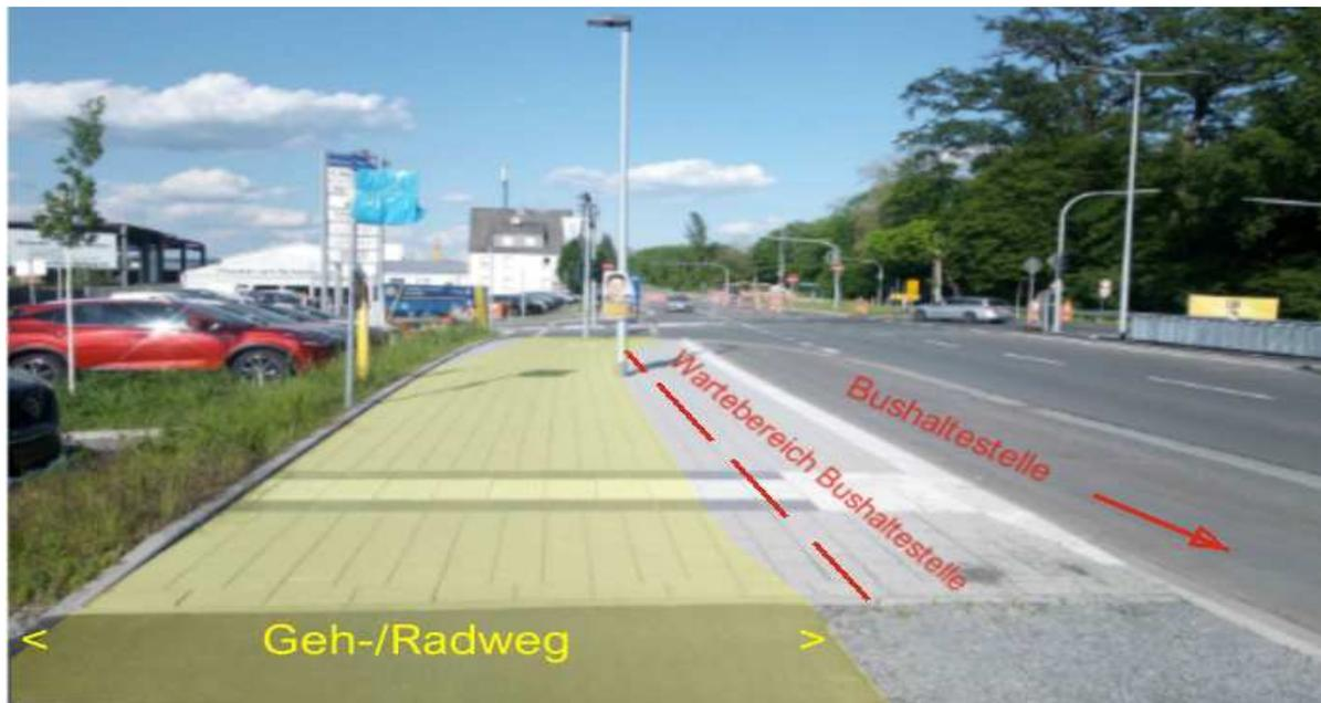
Der Radweg wird im Zweirichtungsverkehr über die Haltestelle geführt (Bild 12). Der Verkehrsraum ist großzügig bemessen. Allerdings wird sich der Radverkehr nicht nur auf die hier gelb dargestellten Fläche beschränken. Es besteht die Gefahr eines Konflikts mit den Wartenden (ERA 3.11).
